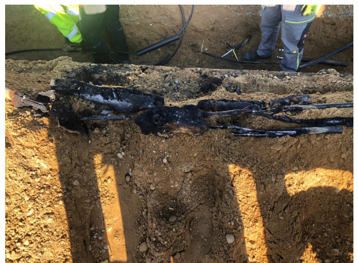
Kabelbrand in der Blumenstraße, Egenhofen
